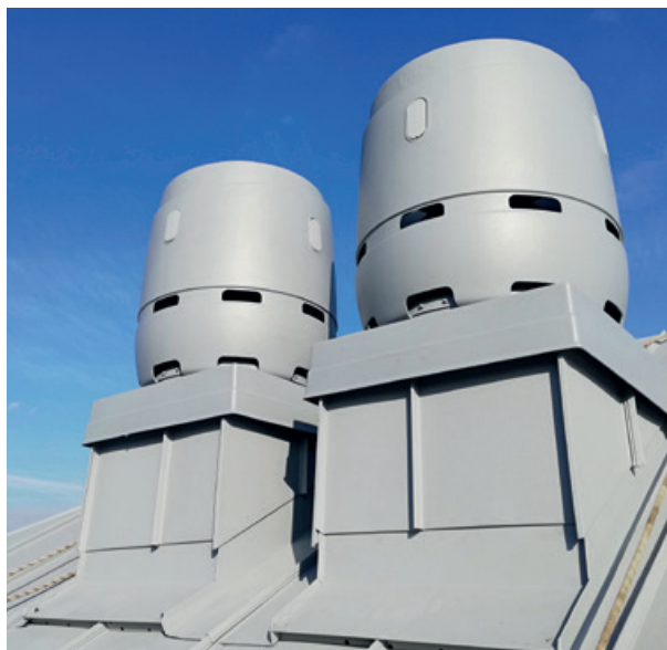
Вентиляционные выходы VILPE FLOW 315/400S серебристо-серого цвета, установленные на скатной крыше. Монтажные коробки на данной фотографии изготовлены заказчиком самостоятельно.
